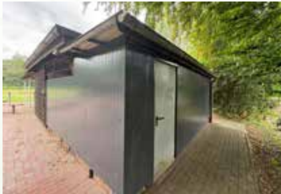
Neues Erscheinungsbild der Hütte an der Außenanlage der Dorfgemeinschaft Wilhelmsfehn.
