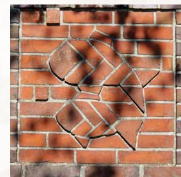
Fische aus Klinker gemauert. Es befinden sich weitere Motive in den Mauern.
