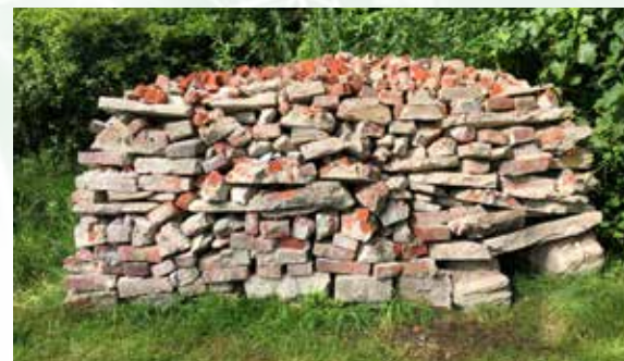
Beispiel einer Trockenmauer. Foto: Helmut Hanssen
