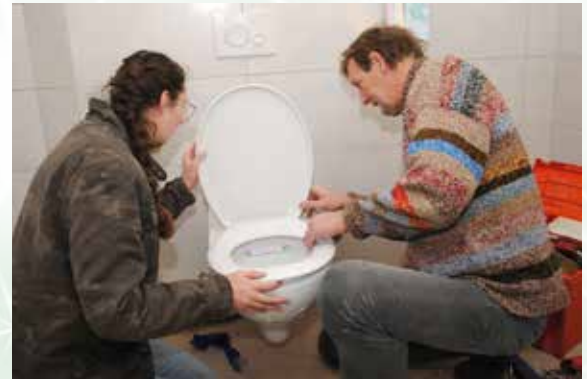
Antje und Alfred Alberts installierten die Toilettenanlagen.
