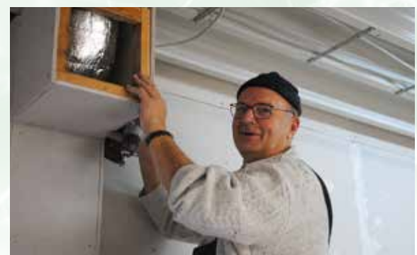
Gerold Gerdes lässt Abflussrohre im Theatersaal verschwinden.
