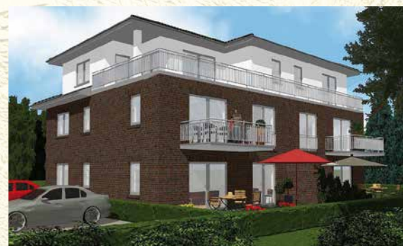
Mehrfamilienhaus mit Penthouse
