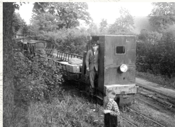
Eine Lokomotive der Feldbahn mit Lokführer Dirk Aden. Repro: Adams
