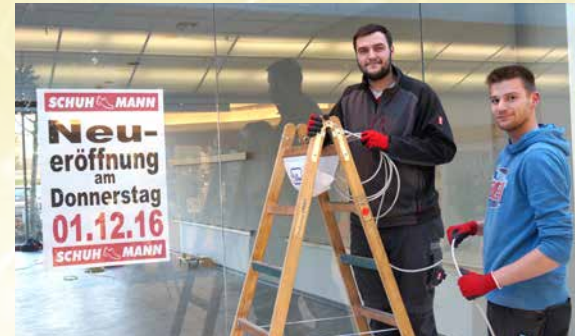
Die letzten Elektroarbeiten werden von Sebastian Müller (l.) und Johannes Hanken (r.) erledigt. Foto: Hoppen
