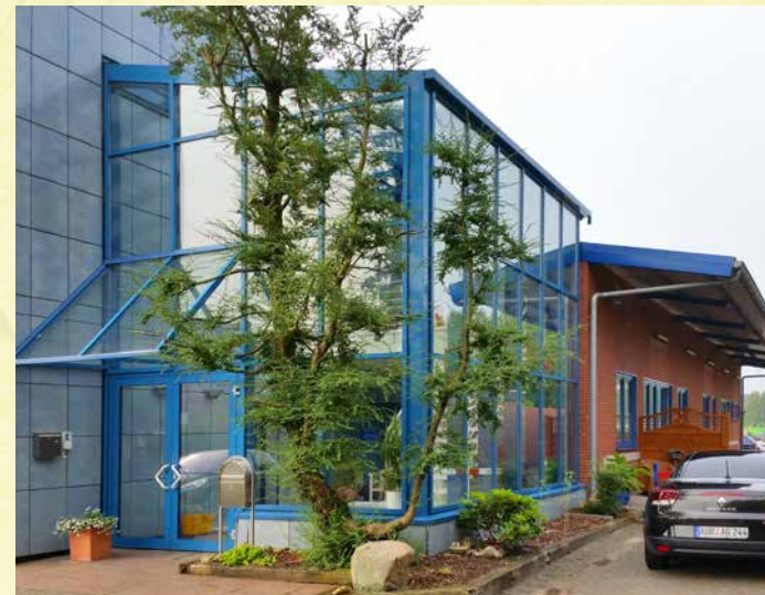
Eingang zum PCC Nord.
