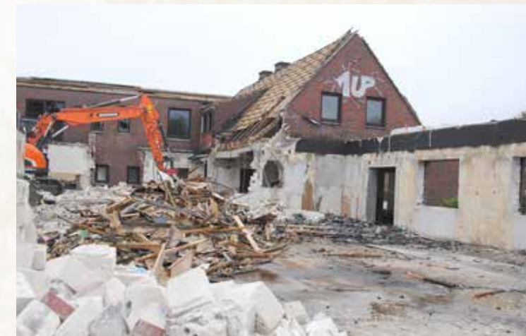
Das Gebäude der ehemaligen Disco „Klövers Danzdeel“ wurde im April abgerissen.
