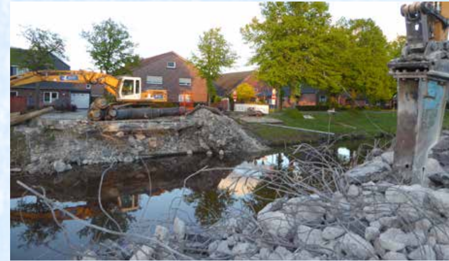
Die „Reste“ der alten Resedawegbrücke.
