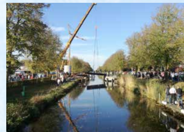
Die neue Brücke im Aufbau. Foto: PRINT MEDIA
