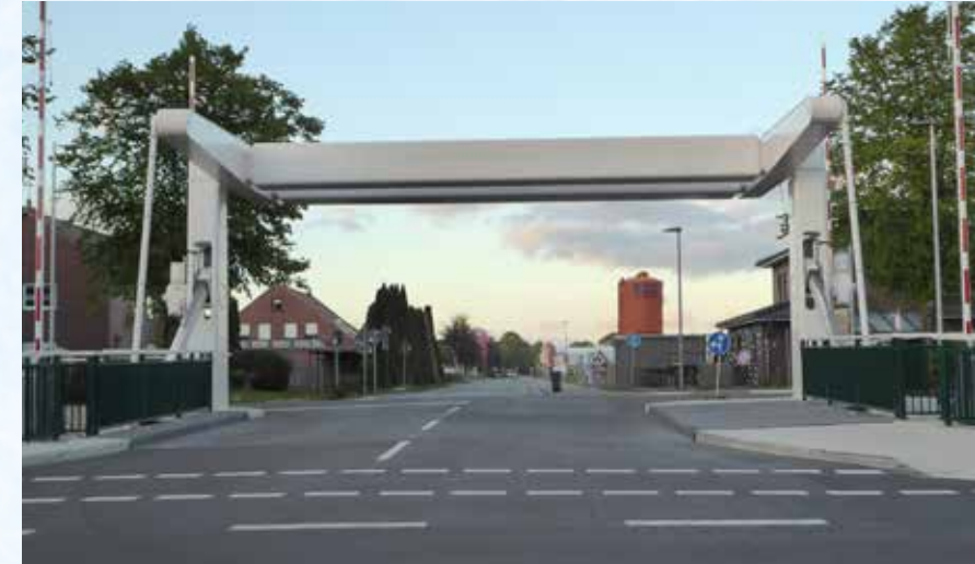
Die neue Amaryllisbrücke.
