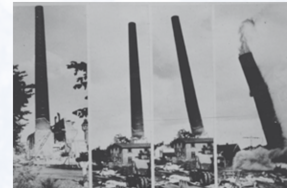
Am 6. Mai 1965, um 13.23 Uhr, wurde der Abriss des Kraftwerkes beschlossen. Unser Foto zeigt den Fall des Schornsteins an der Hauptstraße. Der zweite Schornstein wurde abgetragen.
