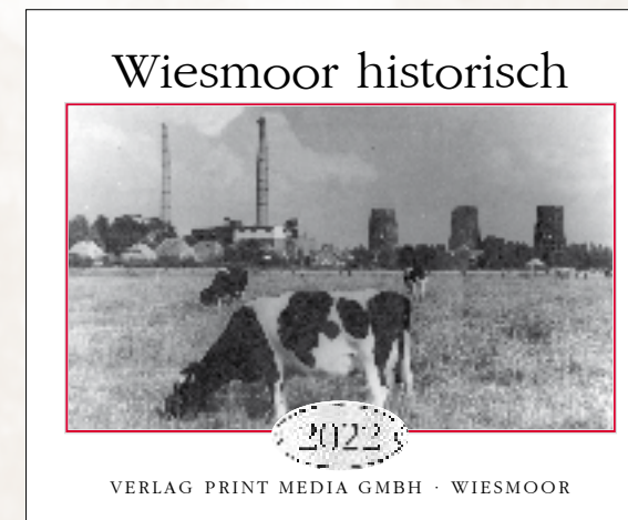
Auch in diesem Jahr zielt wieder ein Foto des Wiesmoorer Kraftwerkes den Kalender.
