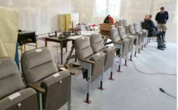
Die erste Stuhlreihe im zukünftigen Theatersaal wurde in Teilen schon mal probeweise installiert.
