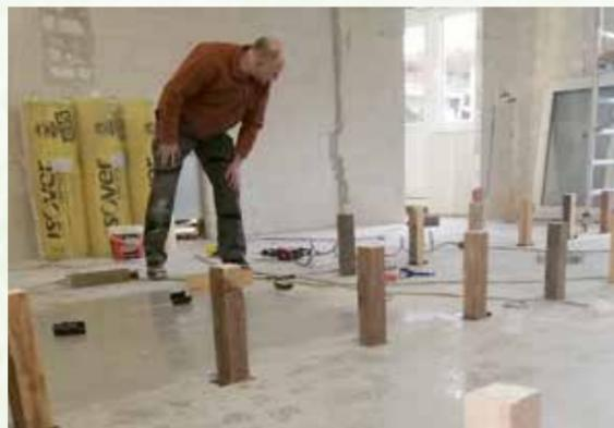
Werner Meyer verankert Holzstützen für die Unterkonstruktion der Bühne im Betonboden.
