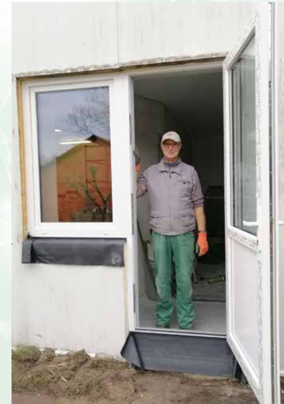
Ein neues Tür-Fenster-Element im rückwärtigen Bereich des zukünftigen Theaters wurde bereits eingebaut. Im Bild ist Bühnenbauer Gerold Gerdes zu sehen.
