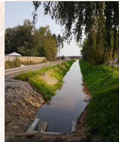
Neuer Graben am Baugebiet A 27 (Mullberger Straße Ost).
