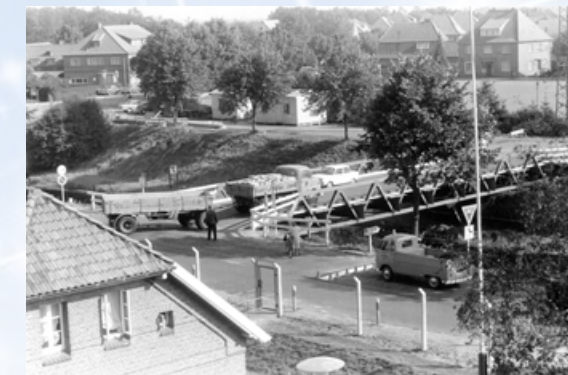
Während des Brückenbaus über den Nordgeorgsfehnlkanal in den 1960er Jahren, gab es eine Behelfsbrücke. Sie stand etwa dort, wo heute die Johanniter ihre Räume haben, also südlich der Hauptkreuzung. Foto: Archiv Frees/Hennek
